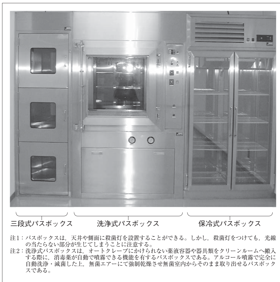
写真7 パスボックス(日科ミクロン提供:各種パスボックス)
