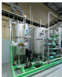
図4.50 原水タンクの外観
